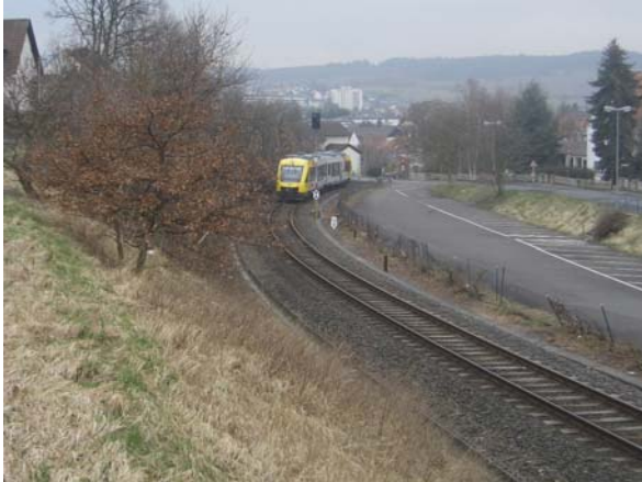
Abb. 6: Böschung an Bahnstrecke
