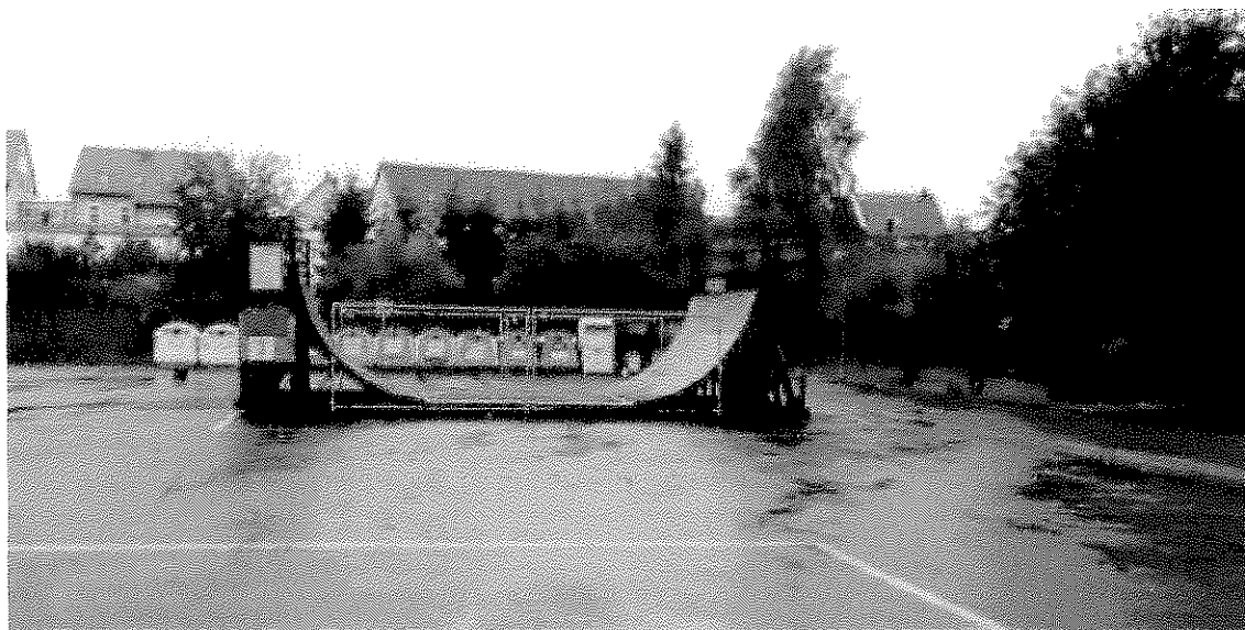
Ansicht Halfpipe – in gesichertem Zustand
