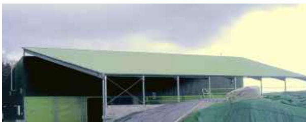
Hier wird die Anlage entstehen: Die Füllhalle der Agrogasanlage
