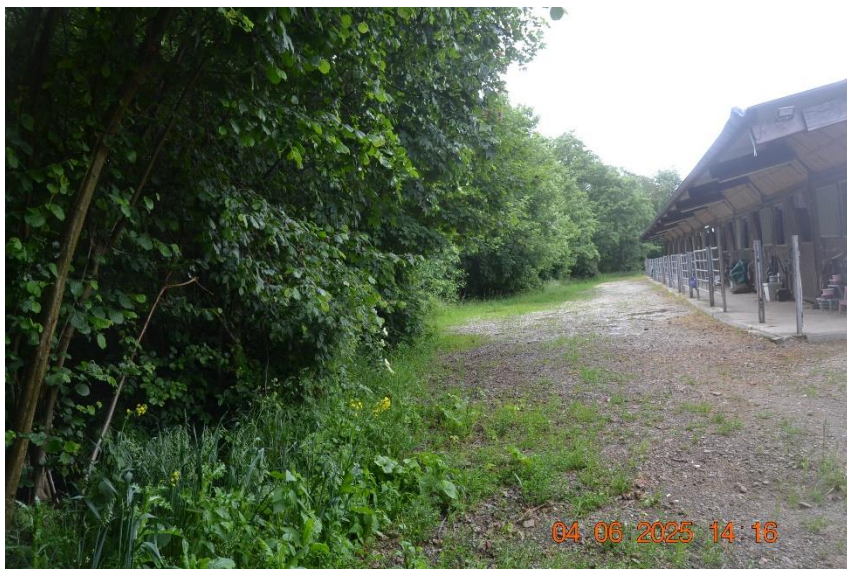
Abbildung 9: Nordansicht der alten Reithalle am Erlenbach.
