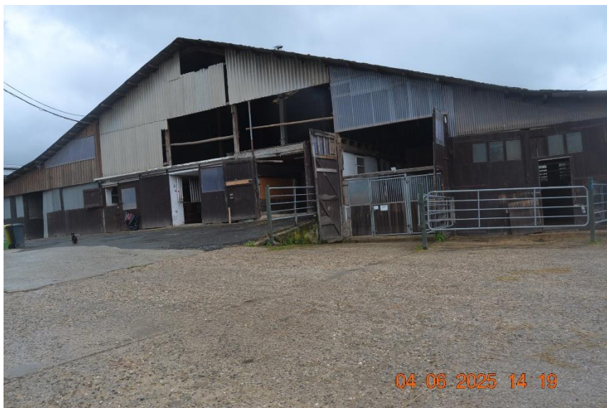
Abbildung 8: Ansicht der zum Abbruch vorgesehenen Bestandshalle im Norden des Geländes (= späterer Standort der neuen Reithalle)
