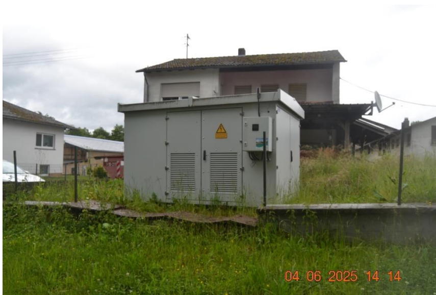
Abbildung 6: Blick vom öffentlichen Weg (Nord-Süd) auf Trafostation und dahinterstehendes Bestandshaus.
