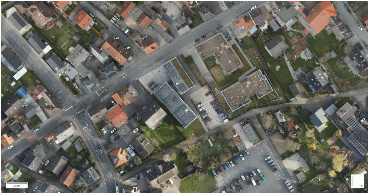
Abbildung 11: Detailliertes Drohnenluftbild von einem Teilbereich des Projektgebiets
