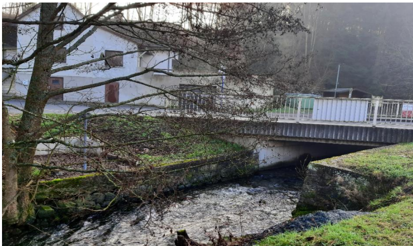
Abbildung 12: Vermessung einer Brücke in Neu-Anspach
