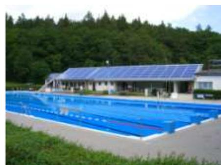
**Abb. 3:** Thermische Solaranlage Waldschwimmbad<sup>4</sup>
