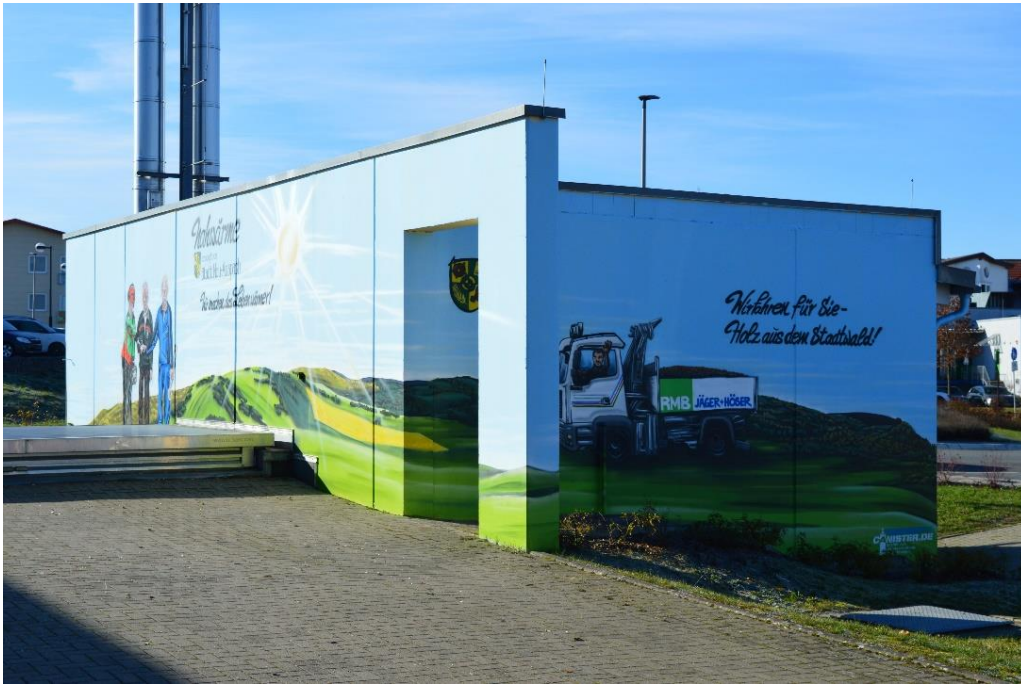
Abb. 2: Holzhackschnitzel-Heizanlage – Daimlerstraße 2 (Foto Stadt Neu-Anspach)
