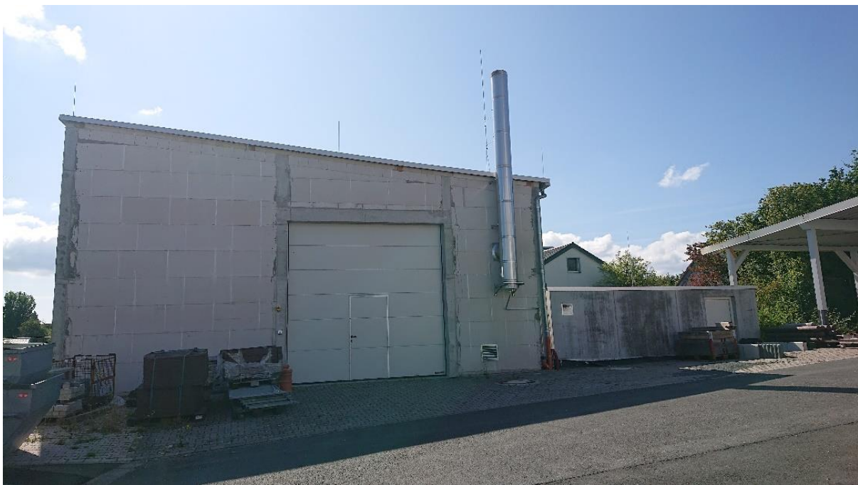
Abb. 6: Holz hackschnitzel-Heisanlage und Hackschnitzel-Silo nach Fertigstellung (Foto Stadt Neu-Anspach)
