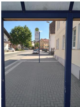
Check: Bushaltestelle Westerfeld: barrierefrei mit Sitzbank/Überdachung
