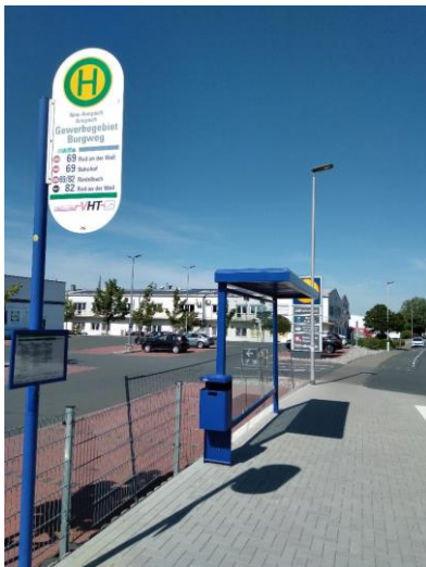
Check: Gewerbegebiet Burgweg: Bushaltestelle barrierefrei, Sitzbank fehlt noch
