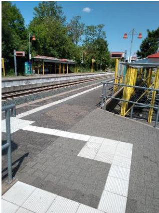
Barrierefreier Zugang zum Bahnsteig durch taktile Bodenelemente auf beiden Seiten
