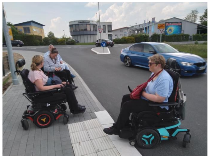
Check: Gehweg und Zufahrtsstraße zum Edeka: Absenkung barrierefrei, aber Wegführung in den PKW-Verkehr
