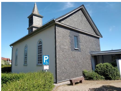
Check: Evang. Kirche Hausen: Barrierefreier Zugang mit Behindertenparkplatz und Behindertentoilette
