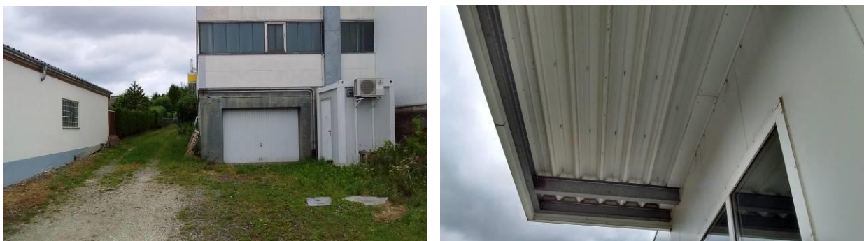
Abb. 3: Blick auf die Außenfassade des Autohauses (links) und unter einen Dachüberstand.
