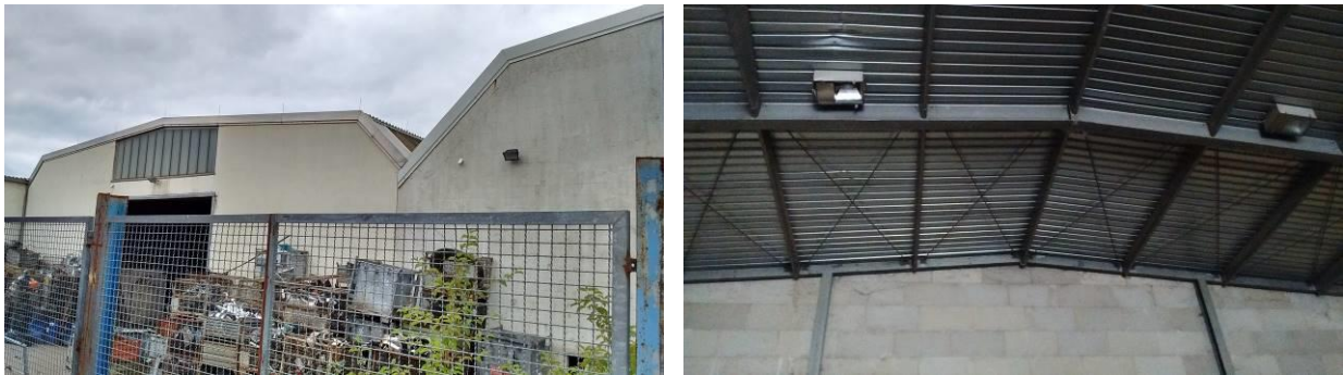
Abb. 4: Blick auf die Hallenfassaden der Altmetallfirma (links) und die Dachstruktur von innen.
